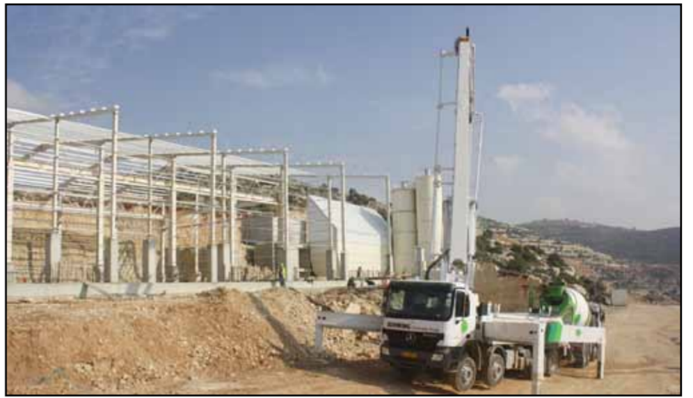
اعمال بناء الهياكل المعدنية في "روابي".
